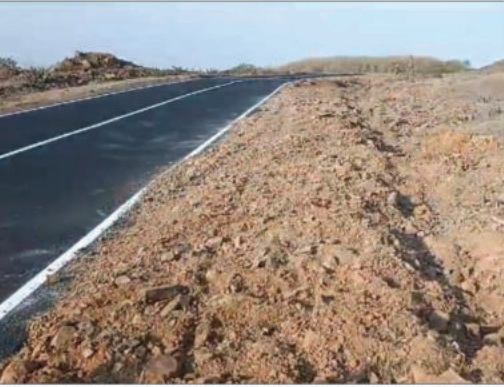
निम्न स्तर के डामर के साथ अक्षत अग्रवाल ने सड़क पर किया सिलकोट, साईड सोलर भी सड़क किनारे से खुदाई कर, कर दी कार्य की इतिहास।
